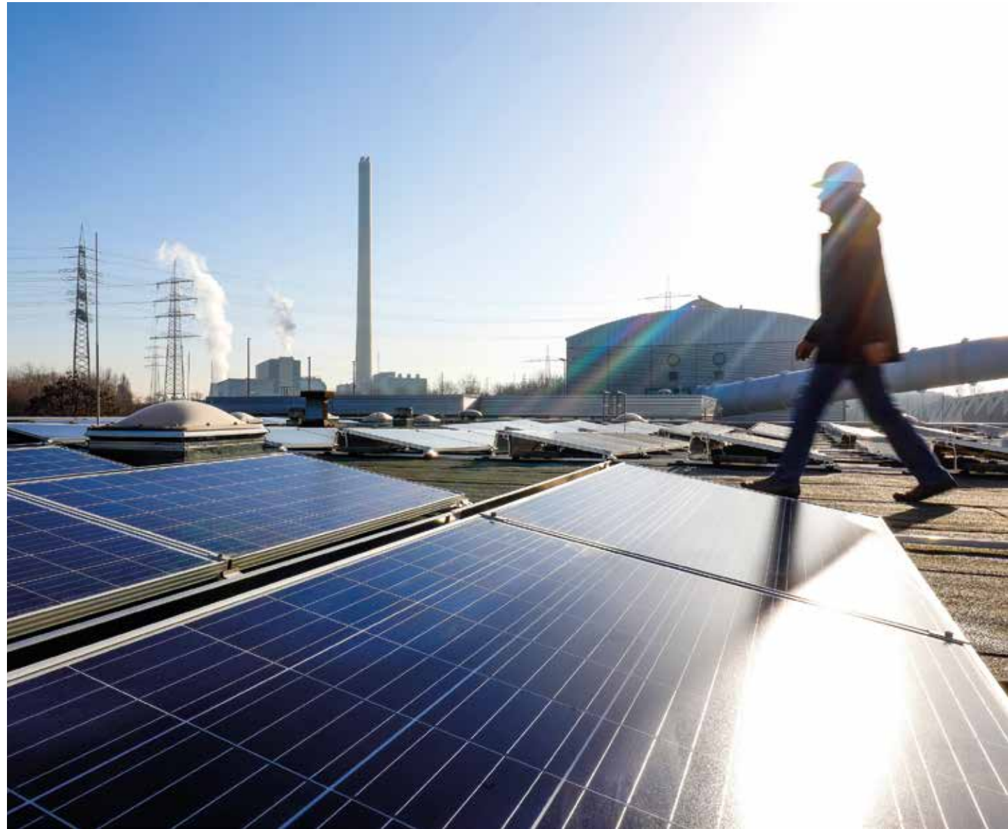
Große Flachdächer eignen sich sehr gut für die Installation von Solaranlagen.
